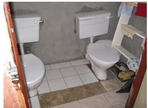
Neue Toiletten in Lindelwas Kindergarten
